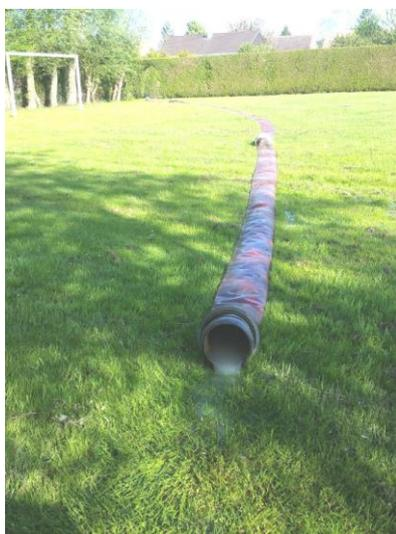
La présence d'eau à 1.50 mètre a nécessité le pompage et le rejet des eaux pompées sur le terrain de jeu.
