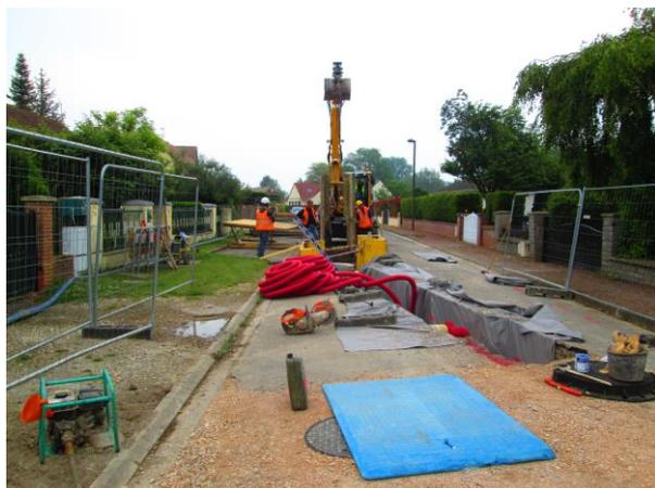
Les travaux Rue de la Gare ont débuté le 2 mai par l'installation d'un poste de refoulement au point bas de la chaussée.
