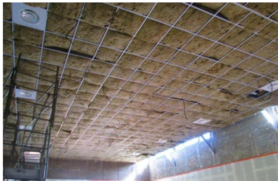
Faux plafond acoustique et isolation avec laine de roche
