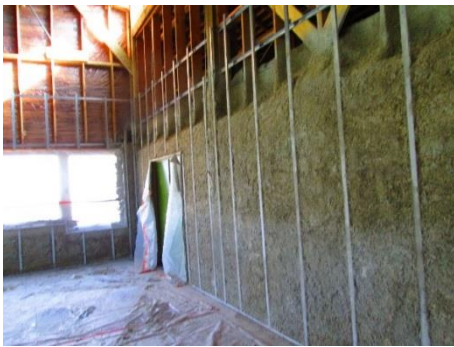
Isolation par 30 cm de béton de chanvre recouverts par un fermacell (sorte de placo) jusqu'à la hauteur de 3 mètres 50
