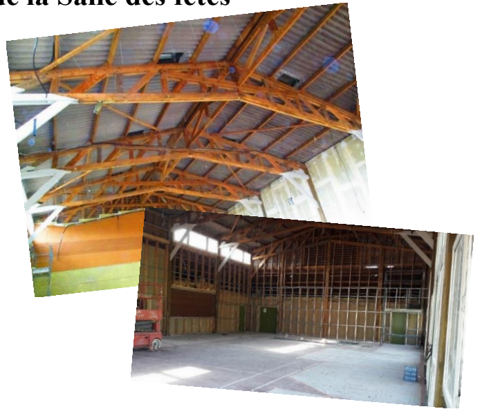
Déshabillage des cloisons ... et du plafond
