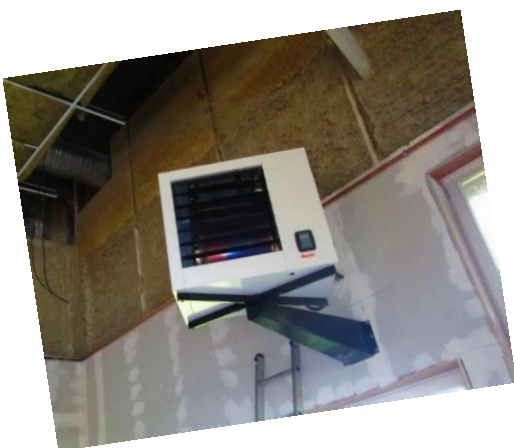
Chauffage par 2 Aérothermes au gaz à haut rendement
