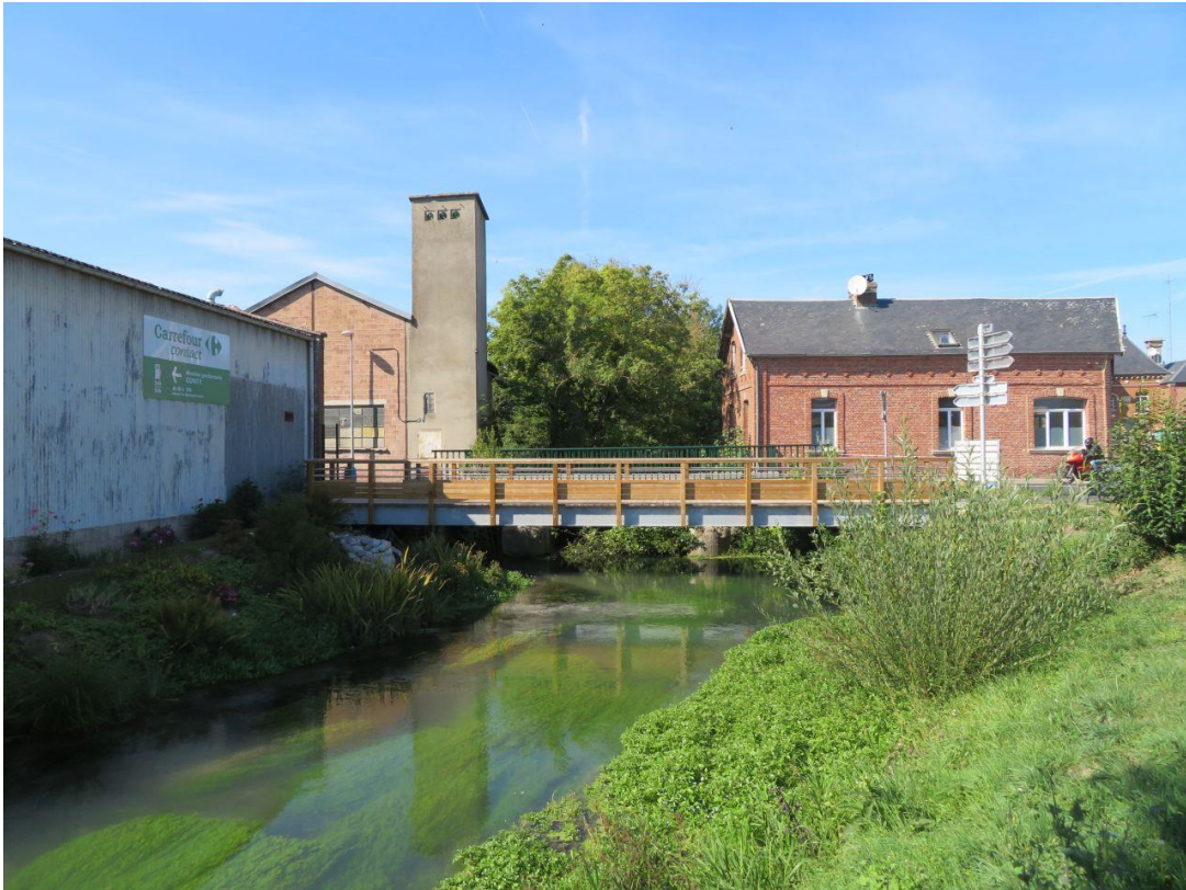
Scierie de la Selle, présence autre moulin pour fabrication de chapeaux (Battersby)
