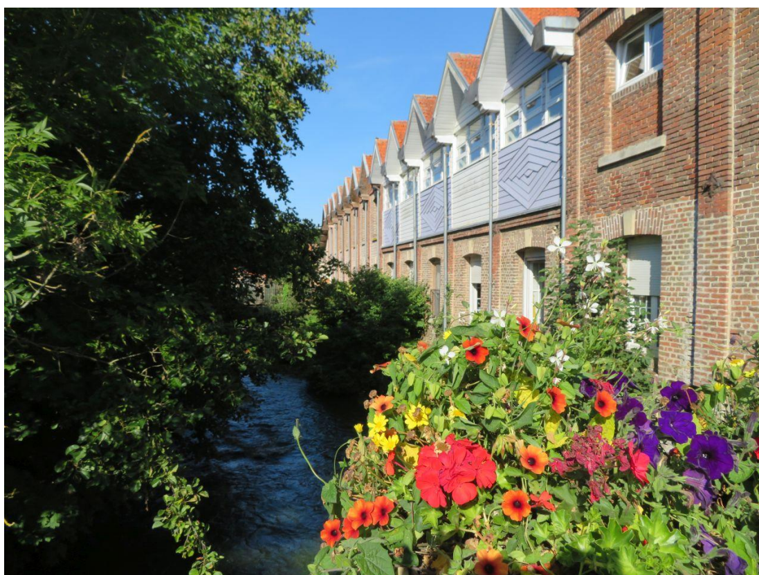
Réhabilitation des locaux d'usine en logements modernes
