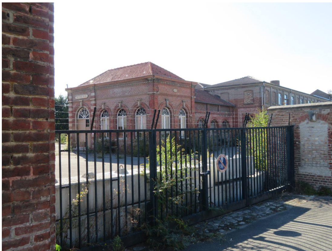
Ancienne usine Cosserat Saleux
