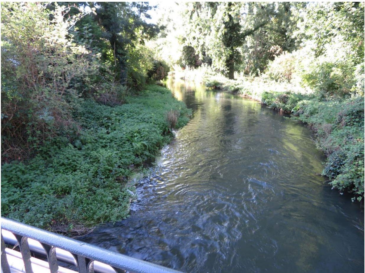
Bras d'alimentation de l'usine
