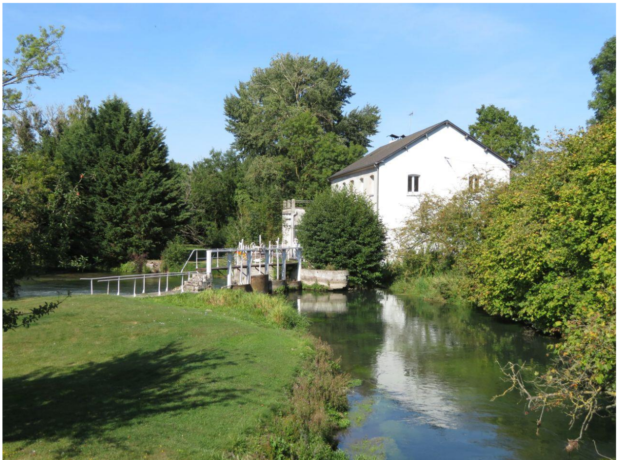
Moulin de Rigauville (moulin à blé puis broyage de pâte à papier pour usine de Prouzel)
