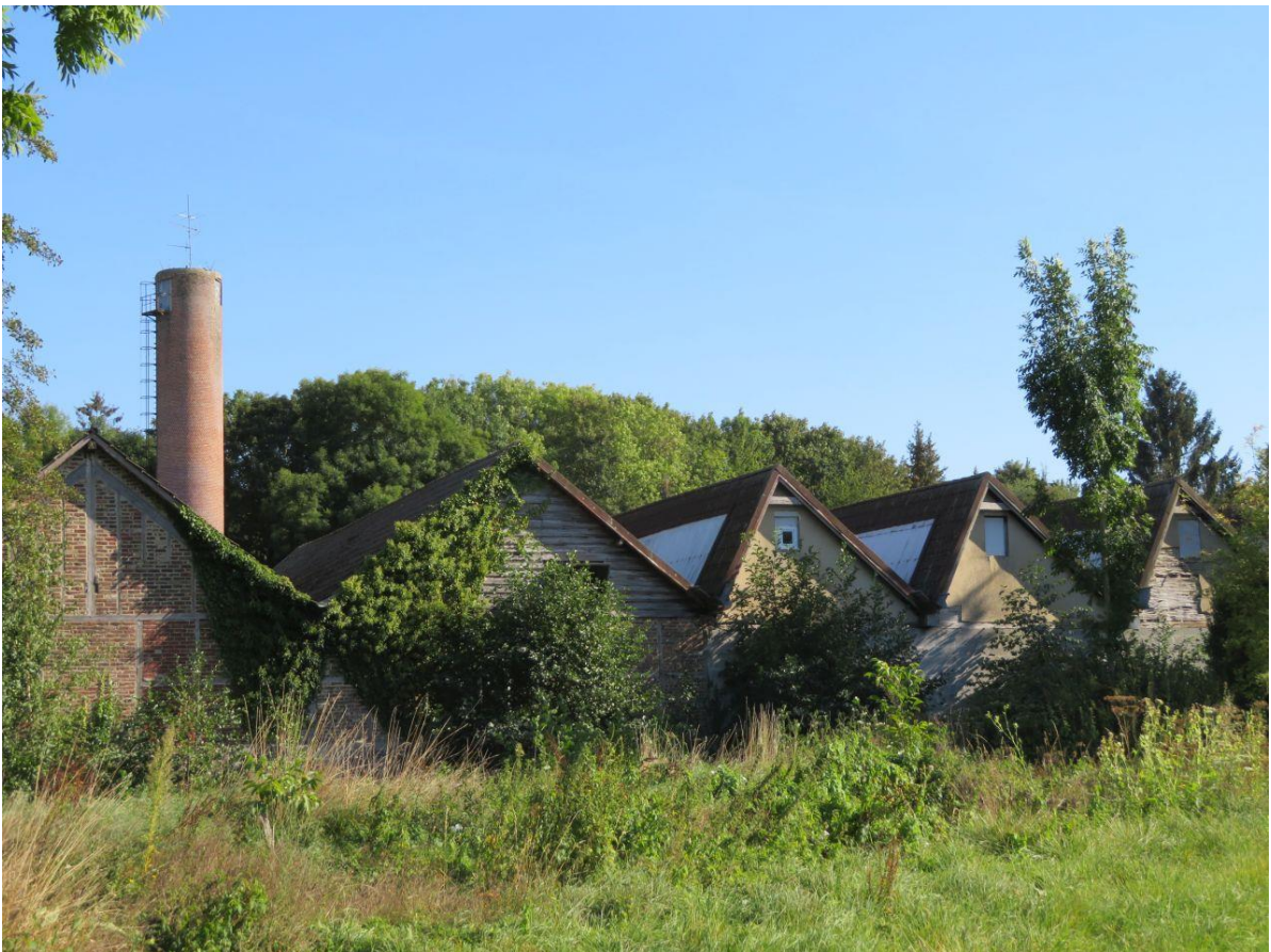
Toits en « Shed » des Ets Siebold Dousinelle permettant un éclairage maximal
